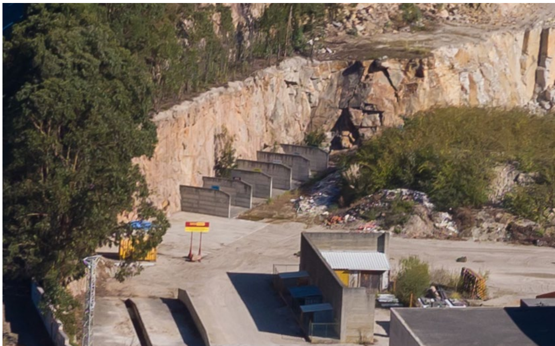
ILUSTRACIÓN 1-2: SILOS DE CLASIFICACIÓN DE RCD'S
