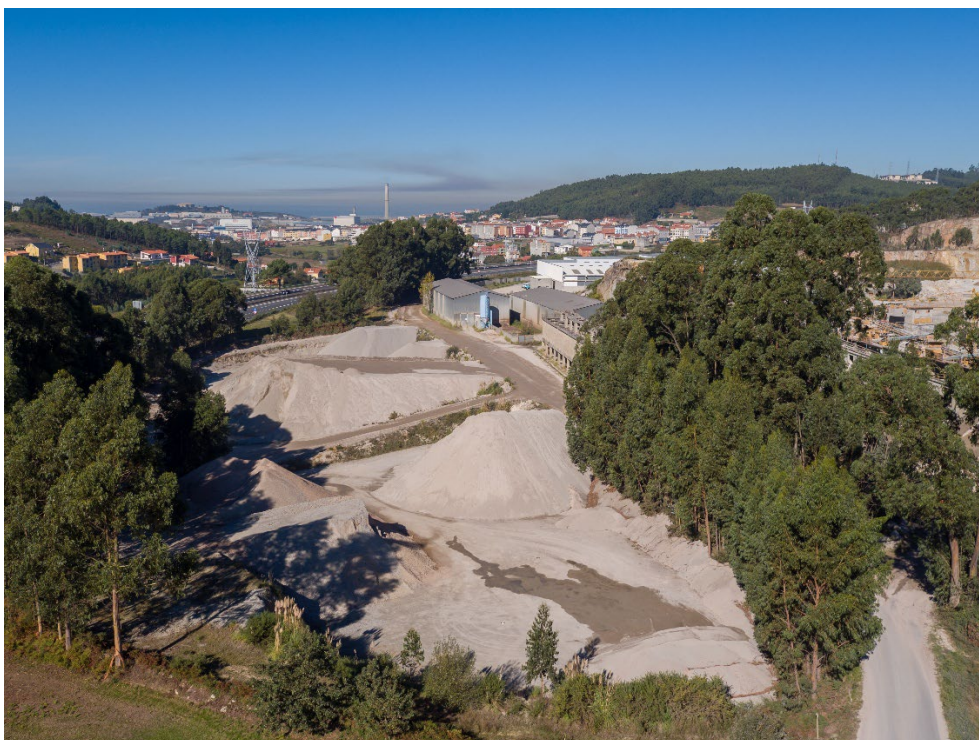
ILUSTRACIÓN 1-4: ZONA DE ACOPIOS.
