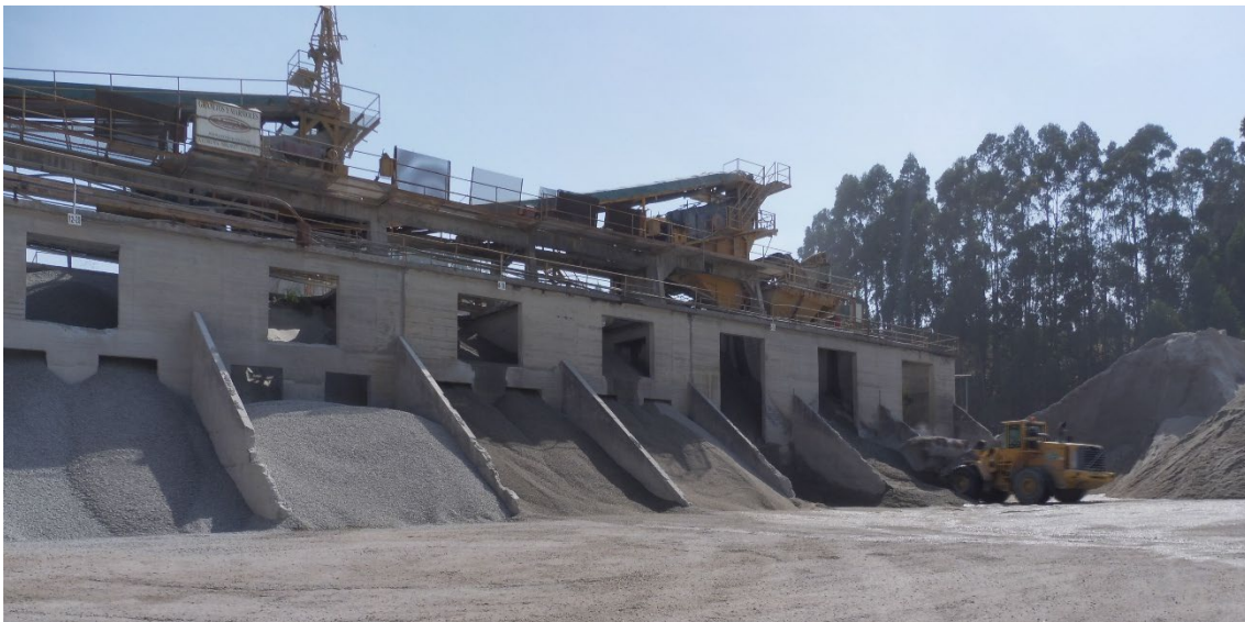
ILUSTRACIÓN 1-6: ZONA DE RECEPCIÓN DE ÁRIDOS YA TRATADOS Y CLASIFICADOS.
