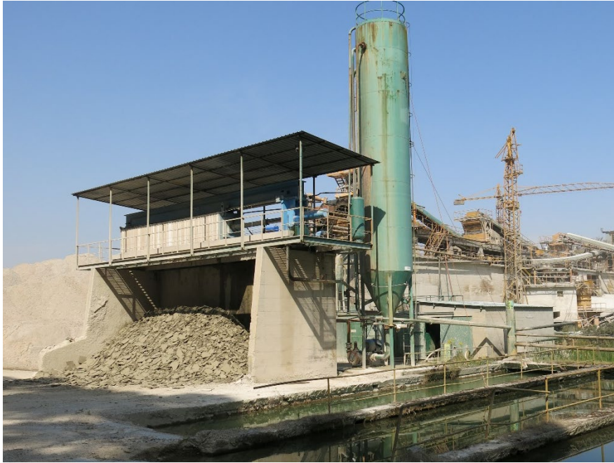
ILUSTRACIÓN 1-5: FILTRO PRENSA PARA DESHIDRATACIÓN DE LODOS PROCEDENTES DE LA PLANTA.
