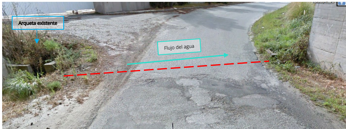
IMAGEN 3-29: TUBO DE DRENAJE TRANSVERSAL A LA RÚA AGOEIROS BAJO EL QUE CIRCULAN LAS AGUAS TRAS INCORPORARSE AL PUNTO DE VERTIDO. .IMAGEN EXTRAÍDA DE GOOGLE EARTH.
