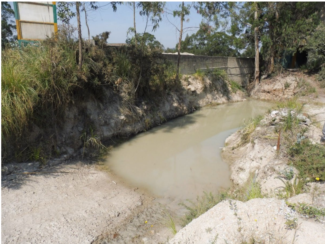
IMAGEN 2-5: DEPÓSITO 2.2 PREVIO A DECANTACIÓN ZONA BÁSCULA. FUENTE: ESMIN INGENIERÍA
