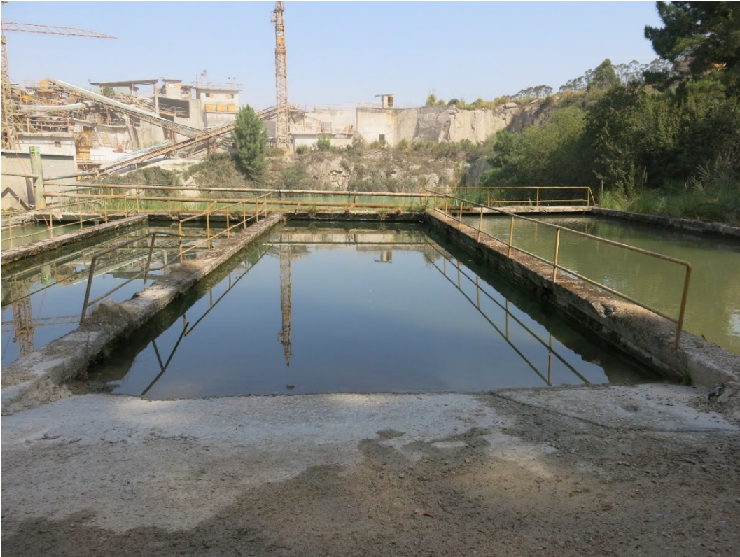
ILUSTRACIÓN 1-3: DEPÓSITOS PARA ABASTECIMIENTO DE LA PLANTA.
