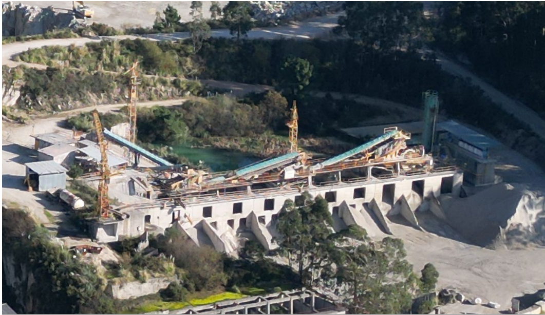
ILUSTRACIÓN 1-1: VISTA AÉREA DEL SUR DE LA PLANTA DE TRATAMIENTO
