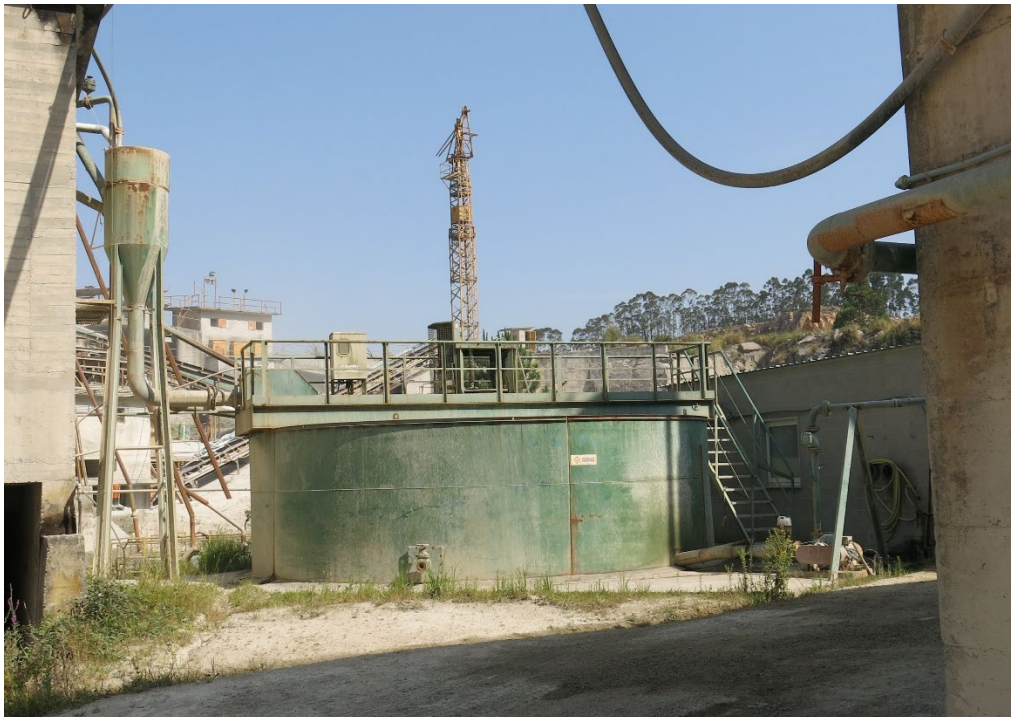
ILUSTRACIÓN 1-4: TANQUE DECANTADOR DEL SISTEMA DE DEPURACIÓN.
