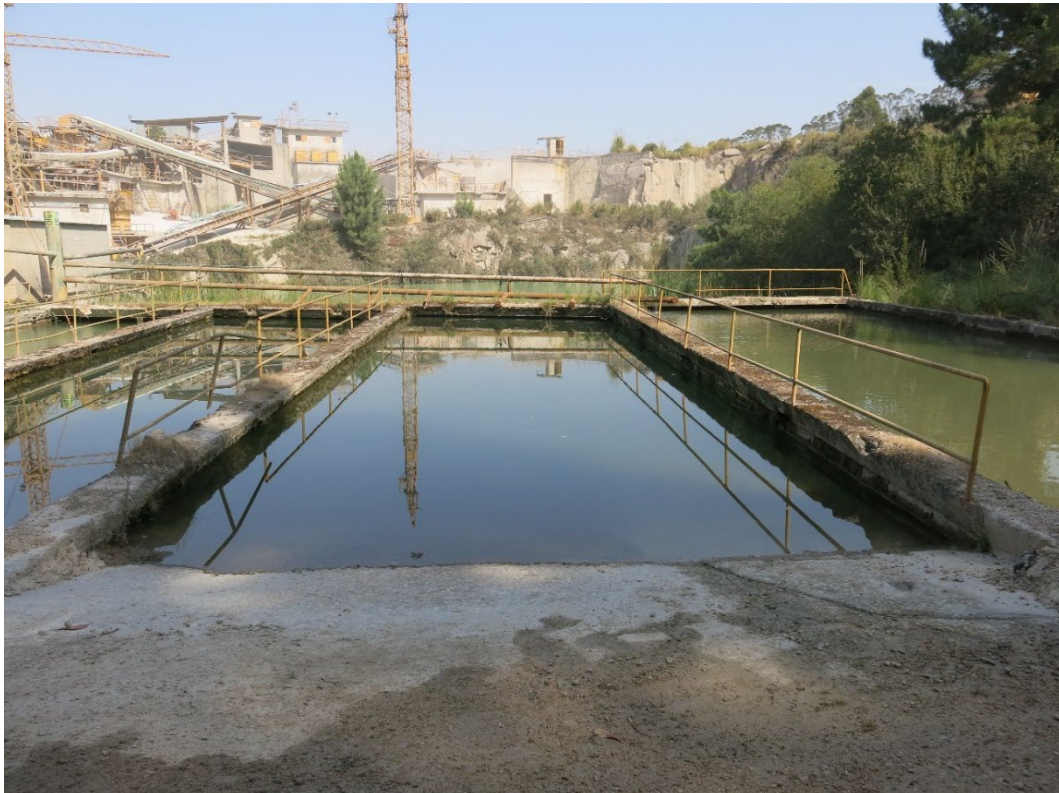
IMAGEN 2-4: DEPÓSITOS PARA ABASTECIMIENTO DE LA PLANTA. FUENTE: ESMIN INGENIERÍA
