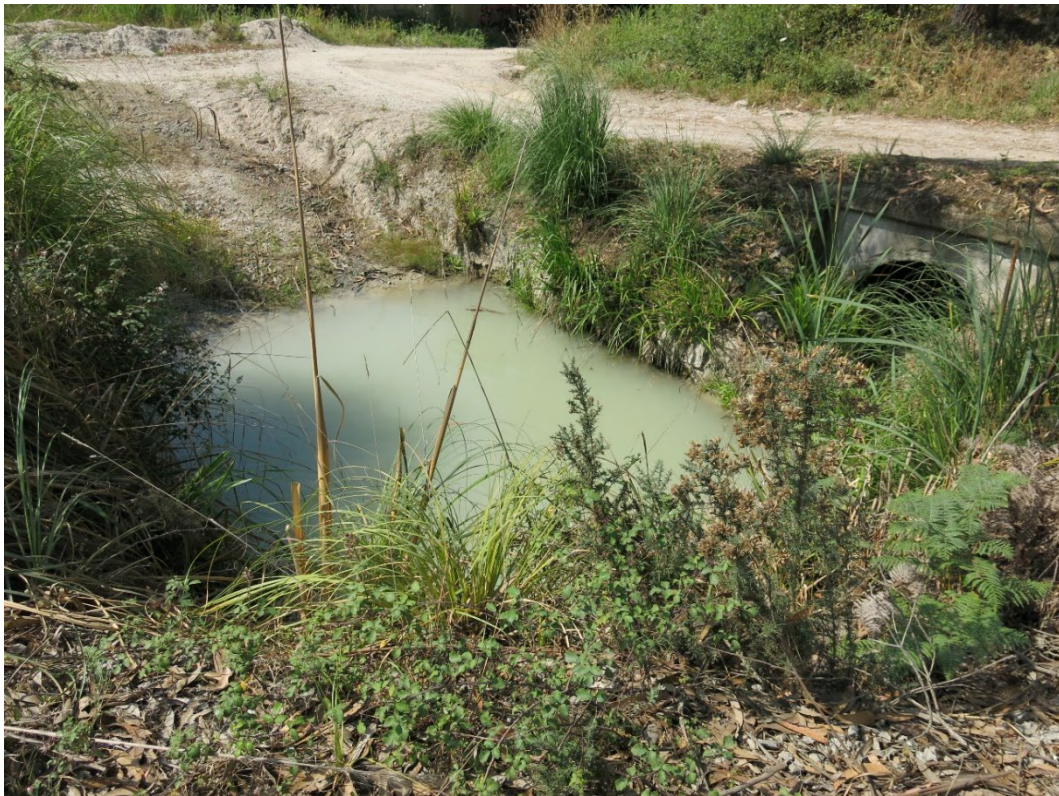
IMAGEN 2-6: DEPÓSITO 2.3 PREVIO A LA DECANTACIÓN. ZONA ACOPIOS. FUENTE: ESMIN INGENIERÍA
