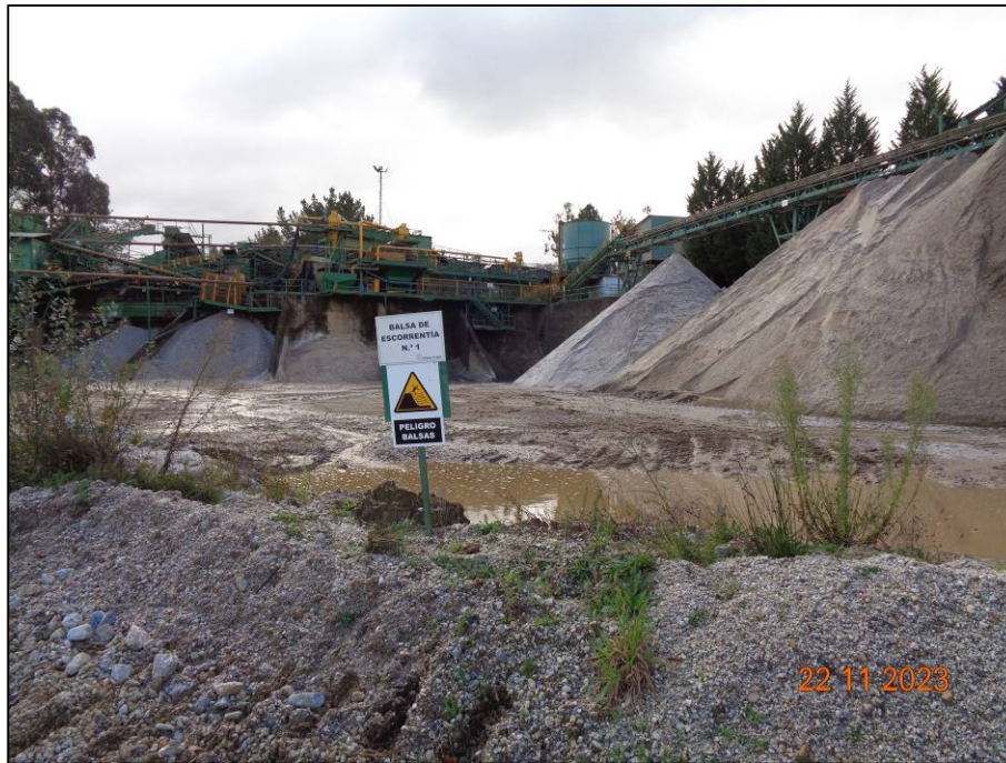
Foto 17. Balsa de escorrentía nº 1.
