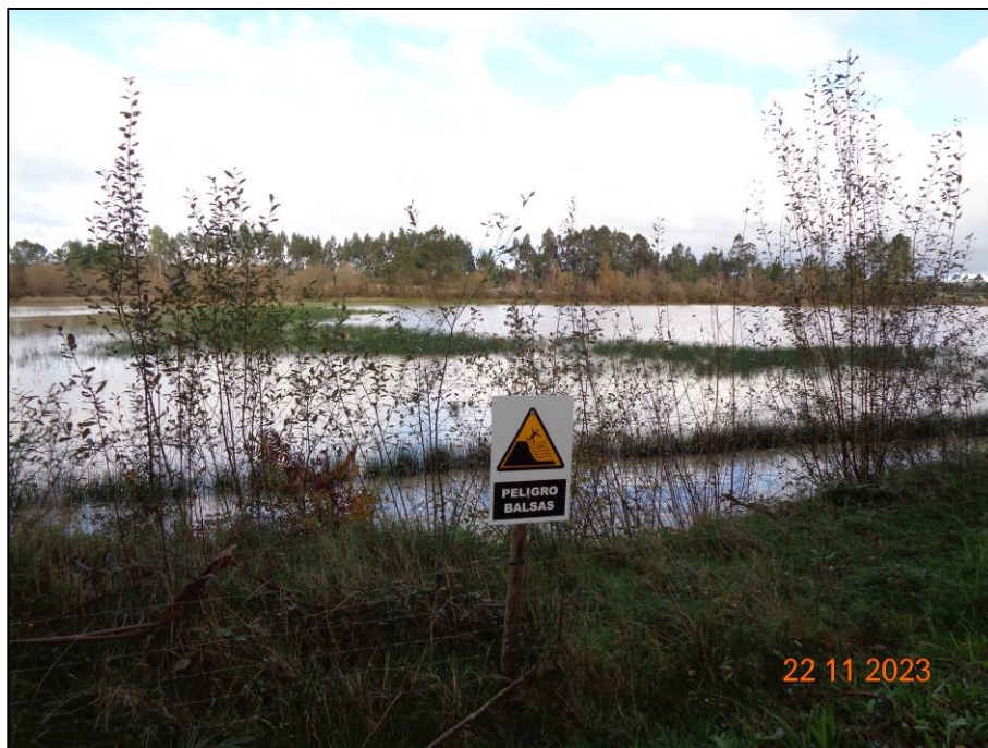
Foto 8. Detalle señalización existente en el acceso circundante del embalse de agua y Balsa 2.
