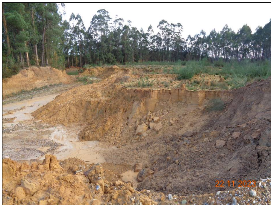
Foto 12. Vista del estado actual de la Balsa 5.
