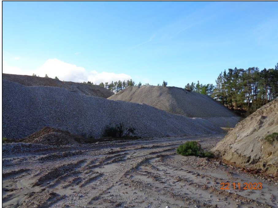
Foto 21. Zona de acopios.
