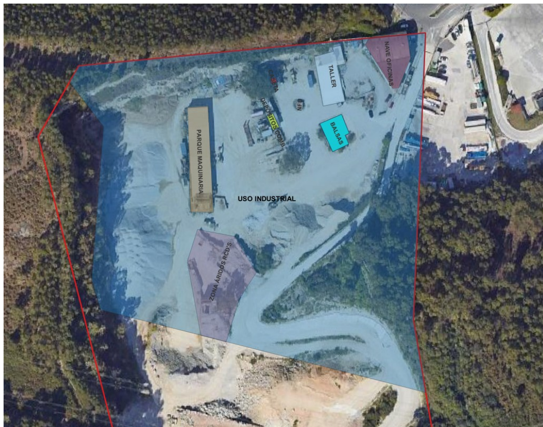
Principales elementos constructivos existentes en la zona de uso industrial
