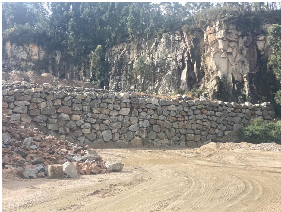
Talud de relleno mediante escollera en plaza de hueco extractivo (zona centro)
